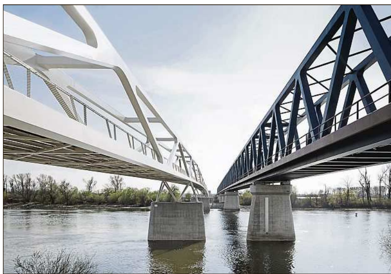
Die Eisenbahnbrücke liegt direkt neben der Fuß- und Radwegbrücke.
