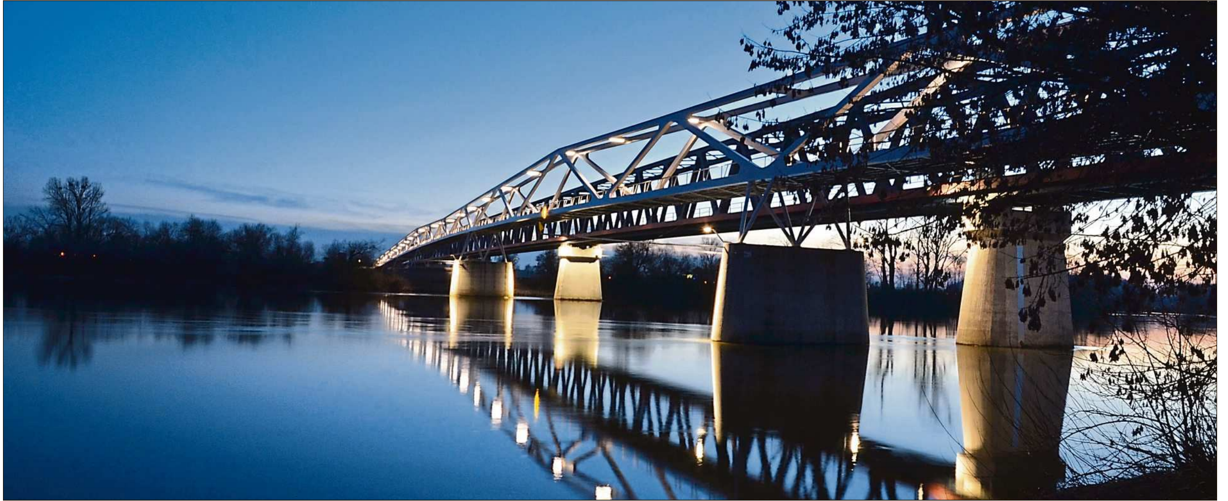
Die neue Fuß- und Radwegbrücke bei Nacht.
